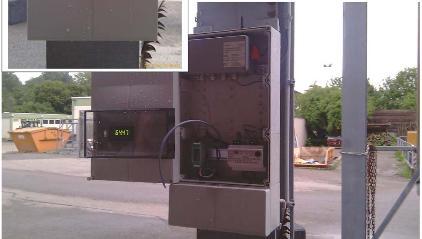
Verdrahtungseinrichtung mit der Montagemöglichkeit des Displays direkt am Silo.
